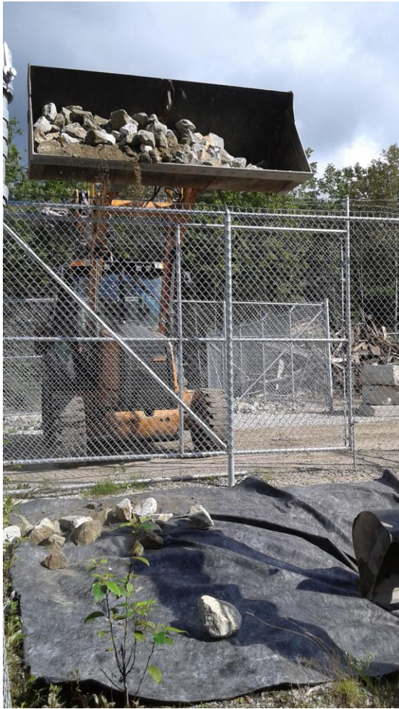
Travaux de stabilisation du talus et d'énrochement préventif
