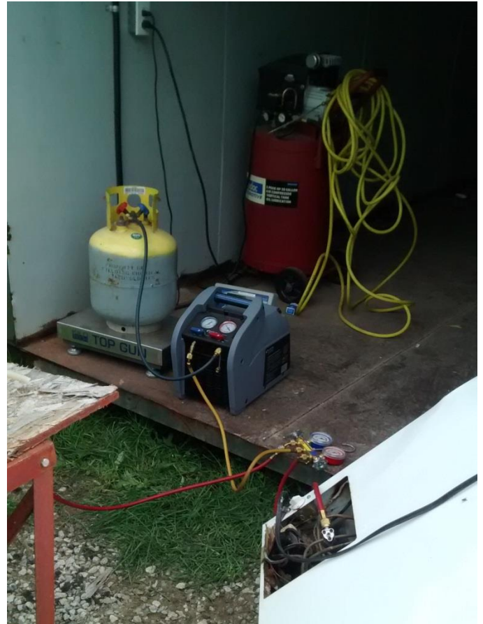
Retrait des halocarbures gazeux d'un congélateur de la part de Marco Gauthier, accrédité pour cette opération, et à l'aide des équipements spécialisés.
