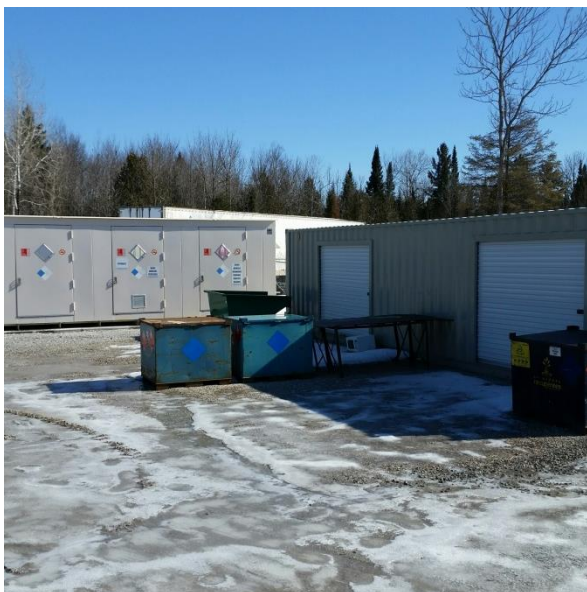
Réaménagement de la zone de réception des RDD et des équipements électroniques
