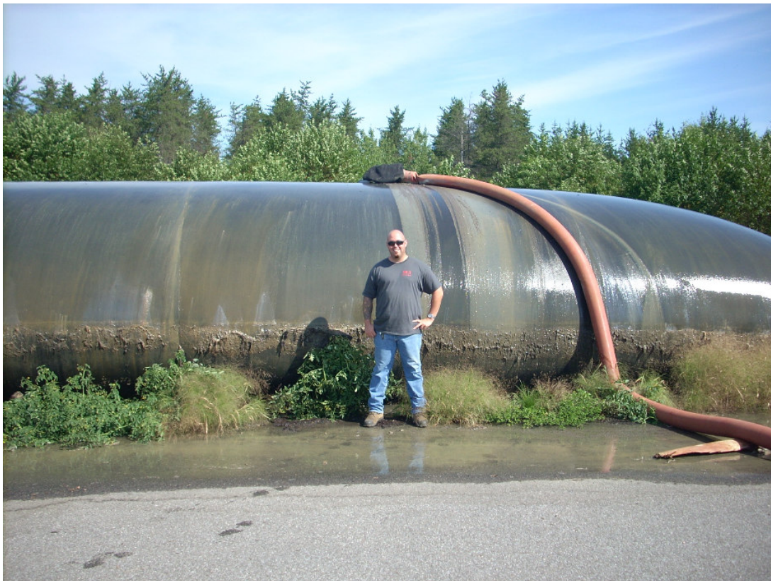
Tube de filtration pour la vidange des boues dans le bassin #4 avec Benoît Lacaille. Notez les plans de tomates qui ont prospéré à proximité.
