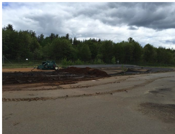
Intégration des sédiments (géotubes) au compost
