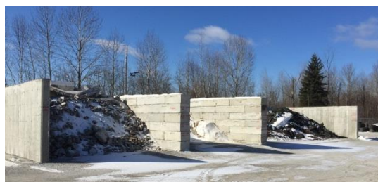
Section sud des nouveaux enclos
