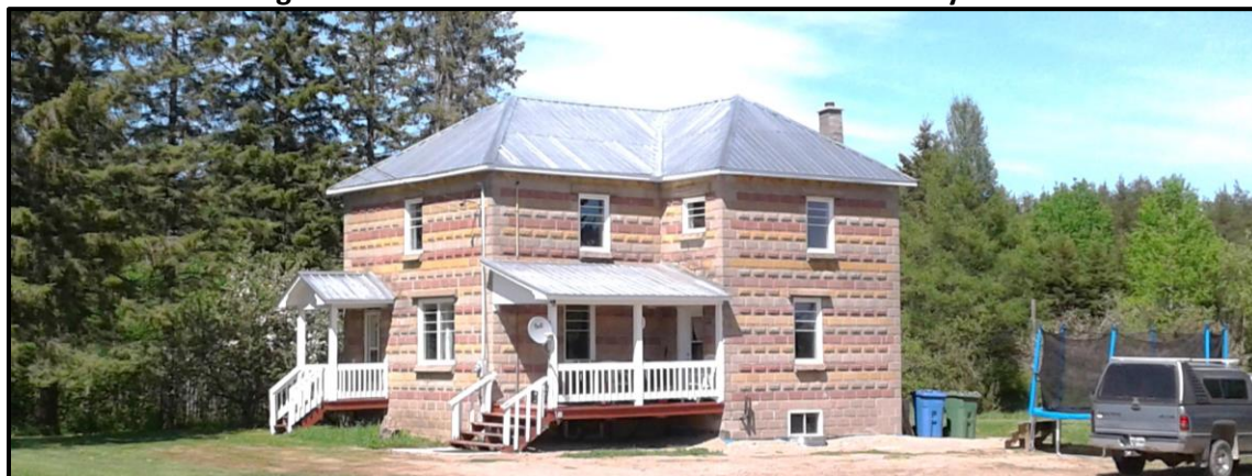
Figure 9.3 : Maison de blocs de ciment à Montcerf-Lytton
