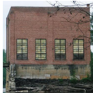
Centrale du Corbeau , Maniwaki 1905 et reconstruction en 1925
