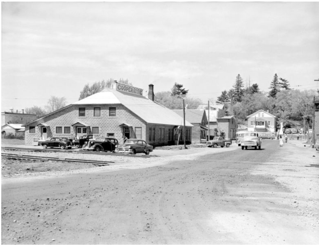
Figure 24 Vue sur les édifices de la Coopérative fédérée à Maniwaki.
