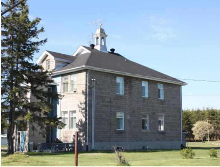
Figure 136 Bergeron, C. (2010) Ancienne école Saint-Raphaël
