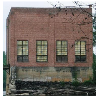
Centrale du Corbeau , Maniwaki 1905 et reconstruction en 1925
