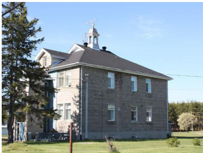
Figure 136 Bergeron, C. (2010) Ancienne école Saint-Raphaël
